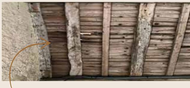
*Cette photo montre l'état d'une partie de la charpente, où des trous sont apparents.*
